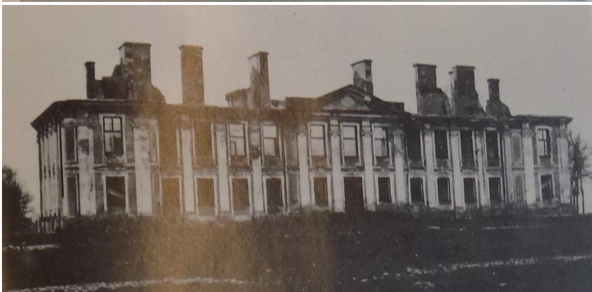
Pałac korpus główny – stan po zniszczeniu 1914-1918 ; Fot. Fabiszewski
